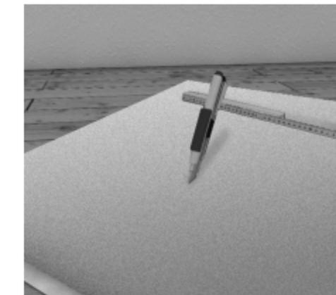
**3. Dämm-Matte mit Cuttermesser auf das benötigte Maß zuschneiden.**
