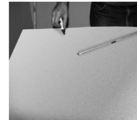
**2. Maße auf Dämm-Matte übertragen. Eventl. Einschnitt für Gurtdurchlass, Motorkabel etc. einschneiden.**
