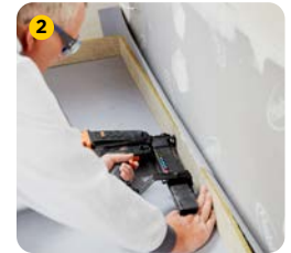
Randdämmstreifen verlegen
