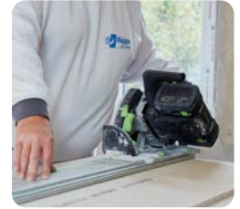
Für den Wandanschluss ist der Stufenfalz abzutrennen
