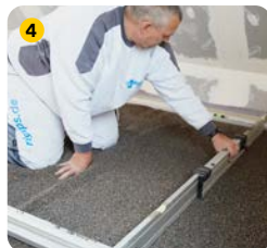
Planebene Schüttungs- oberfläche
