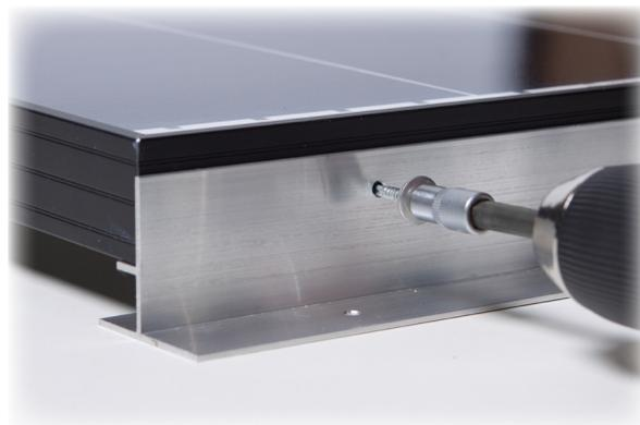
Wenn Sie beide Profilschienen am Modul befestigt haben, legen sie das Modul mit Profilschienen an die Stelle, die Sie zuvor mit Hilfe der Schablone bestimmt haben und markieren Sie diese Stelle. Bei einer Montage von mehreren Modulen sollte darauf geachtet werden, dass das Modul, an dem das lange Kabel befestigt ist (zweites Modul), sich in unmittelbarer Nähe zur vorgesehenen Dachdurchführung (bauseits) befindet.
