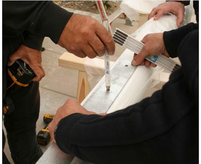
Zeichnen Sie die mit Gewinde vorgebohrten Schraublöcher der einzelnen Pfostenlaschen an die jeweiligen Pfosten an. Bohren Sie mit einem 9mm Metallbohrer vor und schieben Sie die Laschen in den entsprechenden Pfosten. Zeichnen, bohren und verschrauben Sie Lasche für Lasche, da die Bohrlöcher der einzelnen Laschen variieren können!
