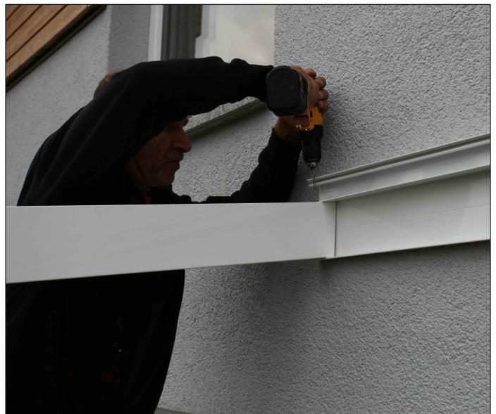
Bohren Sie die Schraublöcher mit einem 4mm Metallbohrer vor und verschrauben Sie die Sparren mit jeweils einer Karoserieschraube (C101-025) an den beiden Pfeften.
