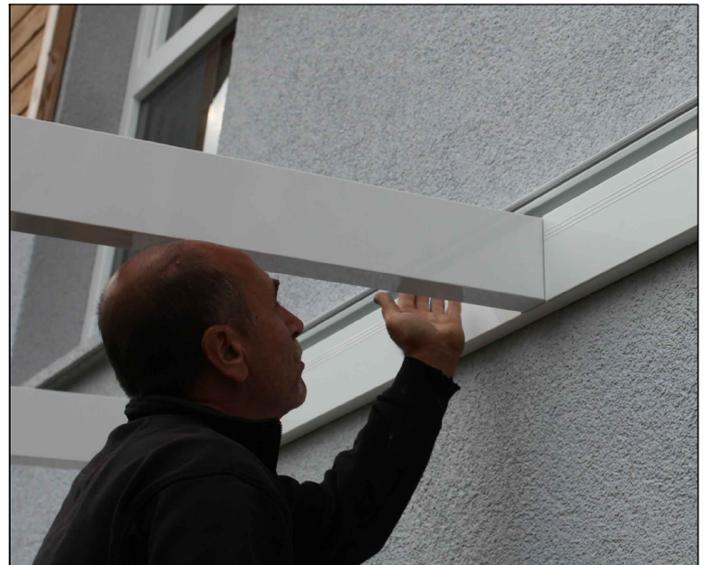
Verteilen Sie die anderen Sparren mit Hilfe der Blendeleisten (dienen als Abstandshalter), bohren Sie die Schraublöcher mit einem 4mm Metallbohrer vor und verschrauben Sie die Sparren mit jeweils einer Karoserieschraube (C101-025) an den beiden Pfetten.
