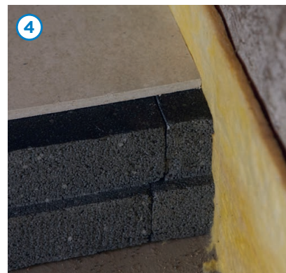
Alternativ kann auch der überstehende EPS-Streifen der letzten Anschlittplatte abgetrennt und an die Wand angelegt werden. Somit lassen sich ganze Elemente einlegen. Wichtig ist, dass eine vollflächige Auflage ohne einen Luftspalt entsteht.
