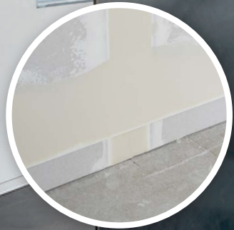
Fertige Abschlusskante mit rückspringendem Sockel
