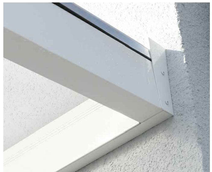
Den Sparren mit einem 4mm Metallbohrer vorbohren und die Blendkappen der Wandfette mit jeweils 2 Schrauben (C101-025) montieren.
